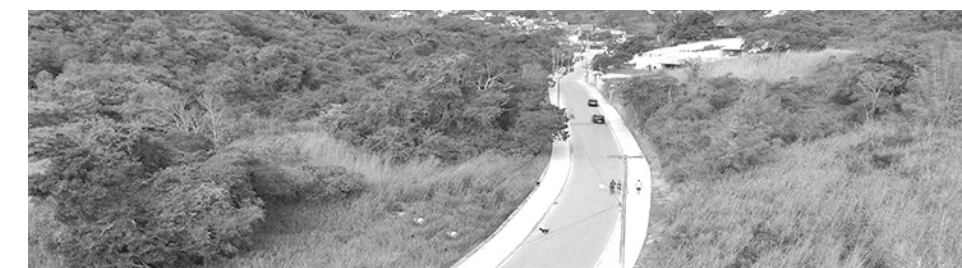
PAVIMENTAÇÃO, DRENAGEM E CALÇADAS DA RUA DA TARTARUGA
