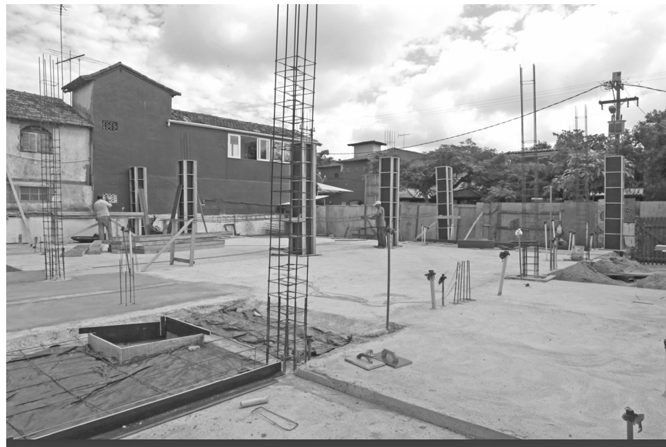
BÚZIOS PREFEITURA CONSTRUÇÃO DA ESCOLA DE GASTRONOMIA
