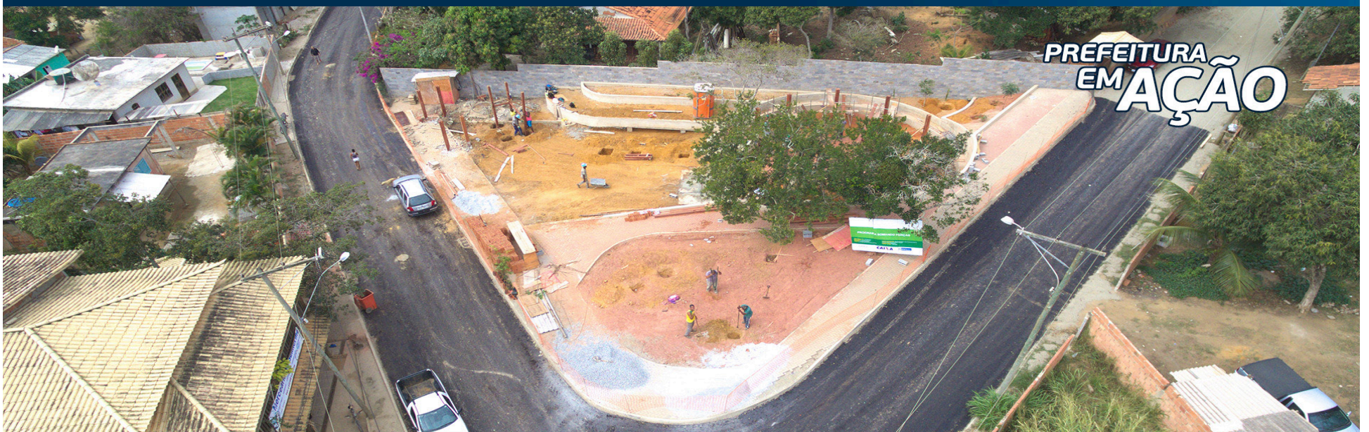
CONSTRUÇÃO DA PRAÇA DA CRIANÇA E DO IDOSO NO BAIRRO BOA VISTA
