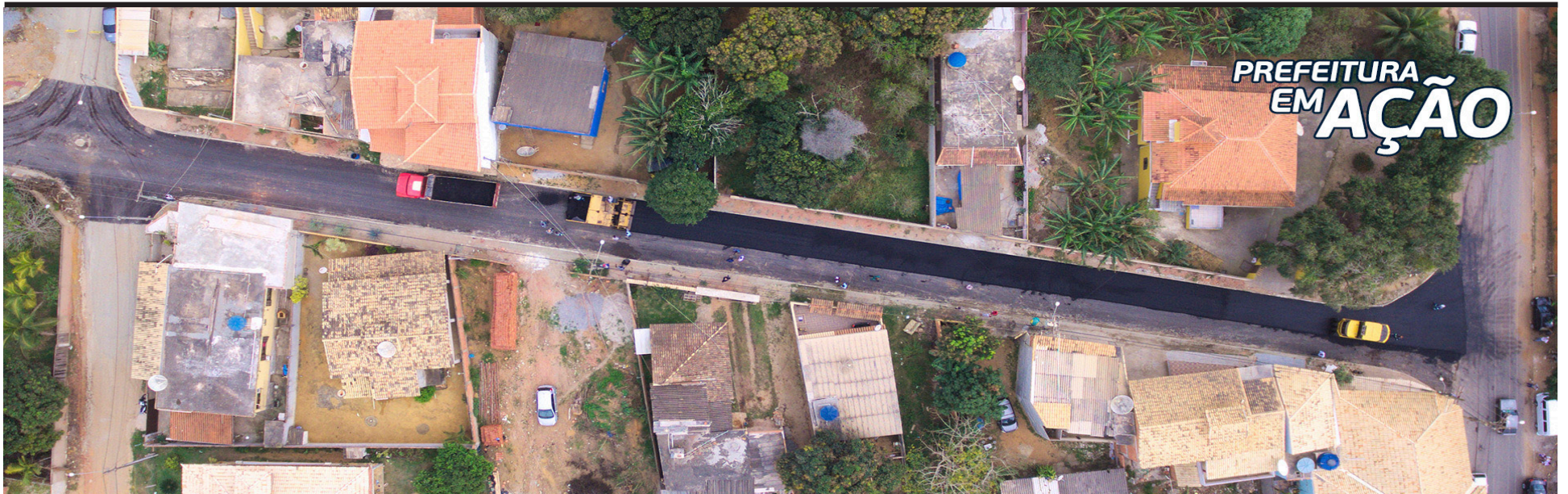
PAVIMENTAÇÃO COM DRENAGEM E CALÇADAS DO BAIRRO BOA VISTA
