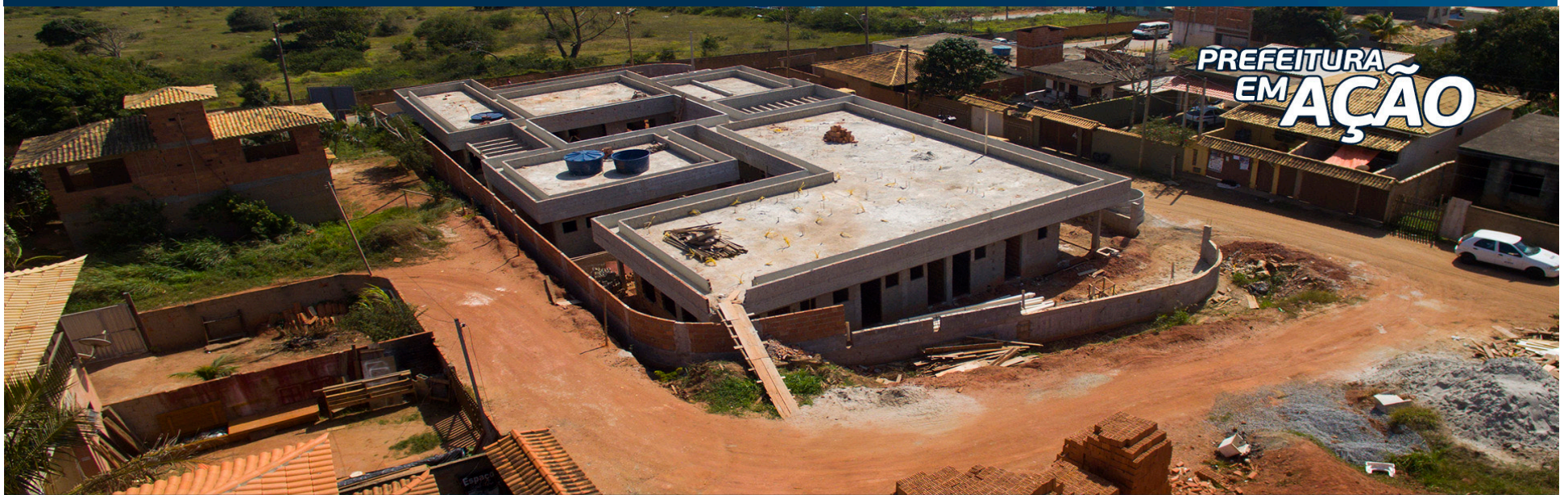
CONSTRUÇÃO DA CRECHE DO BAIRRO BOA VISTA
