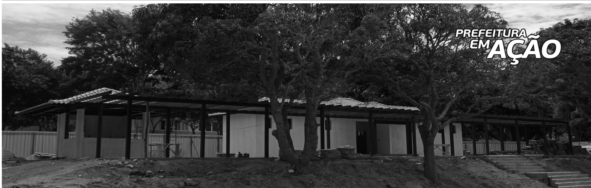
CONSTRUÇÃO DA PRAÇA DO INEFI (VESTIÁRIOS)
