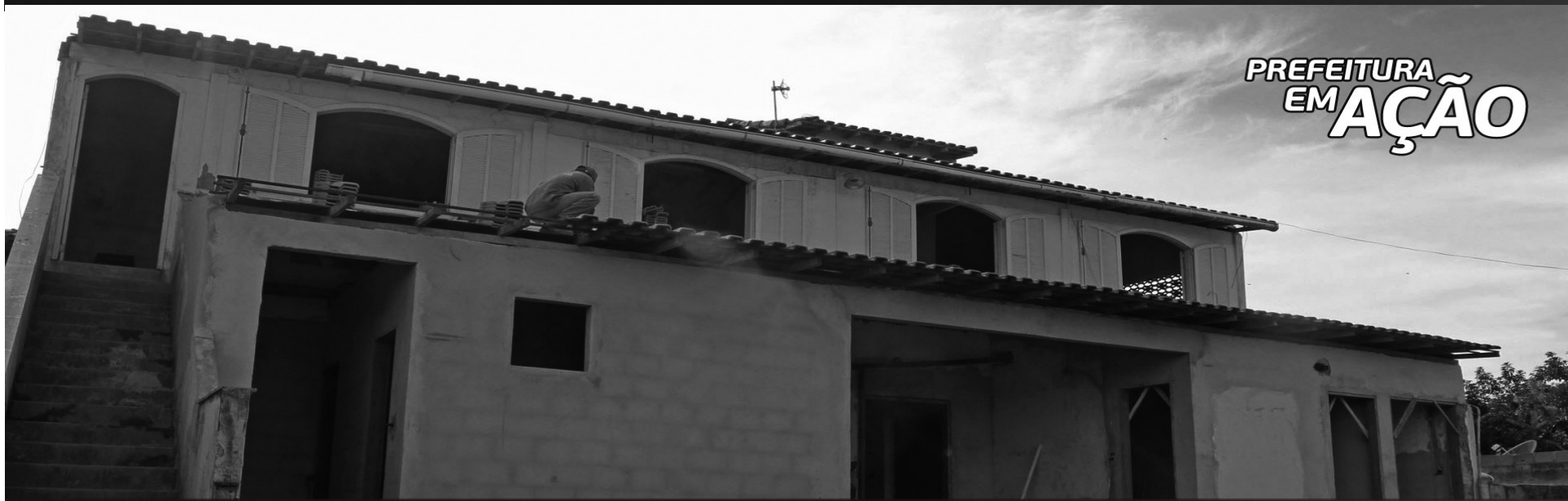
CONSTRUÇÃO DA UBS DA VILA VERDE
