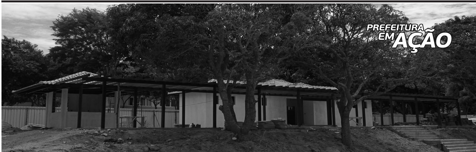
CONSTRUÇÃO DA PRAÇA DO INEFI (VESTIARIOS)
