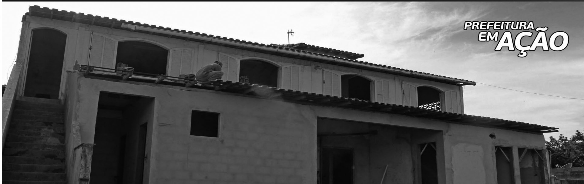
CONSTRUÇÃO DA UBS DA VILA VERDE
