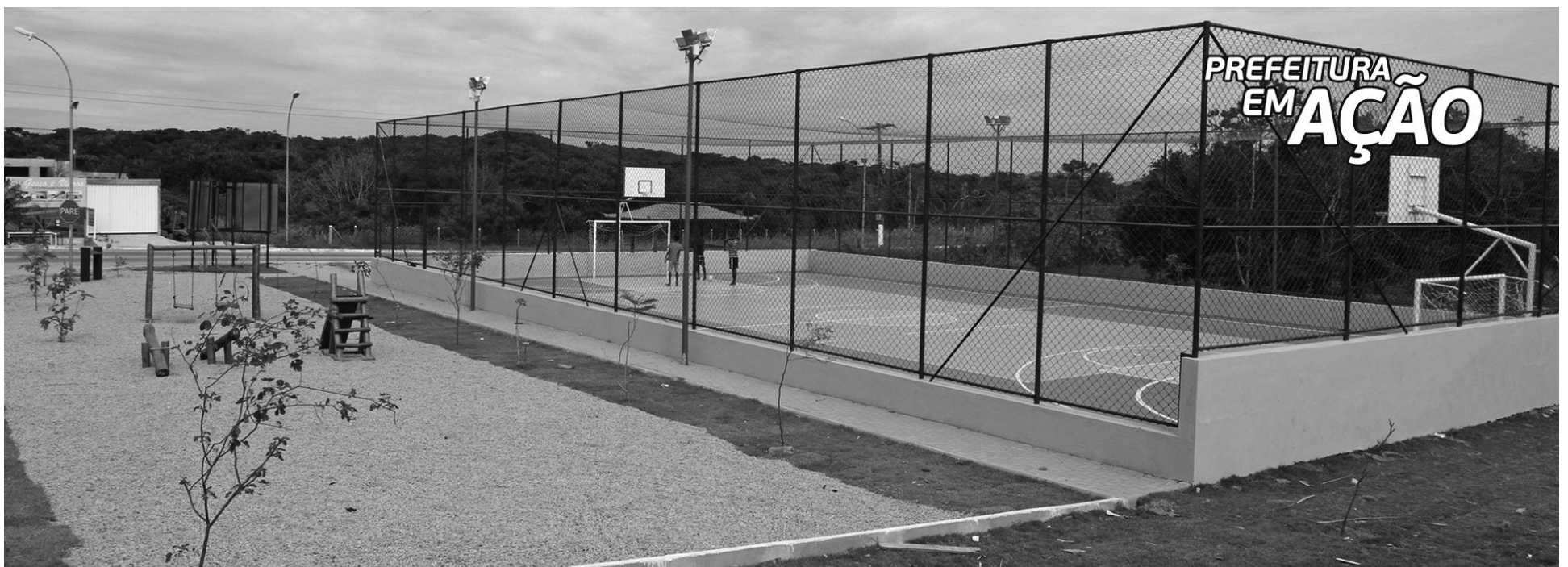
CONSTRUÇÃO DO ESPAÇO DE LAZER DONA NICE NA BAIÁ FORMOSA
